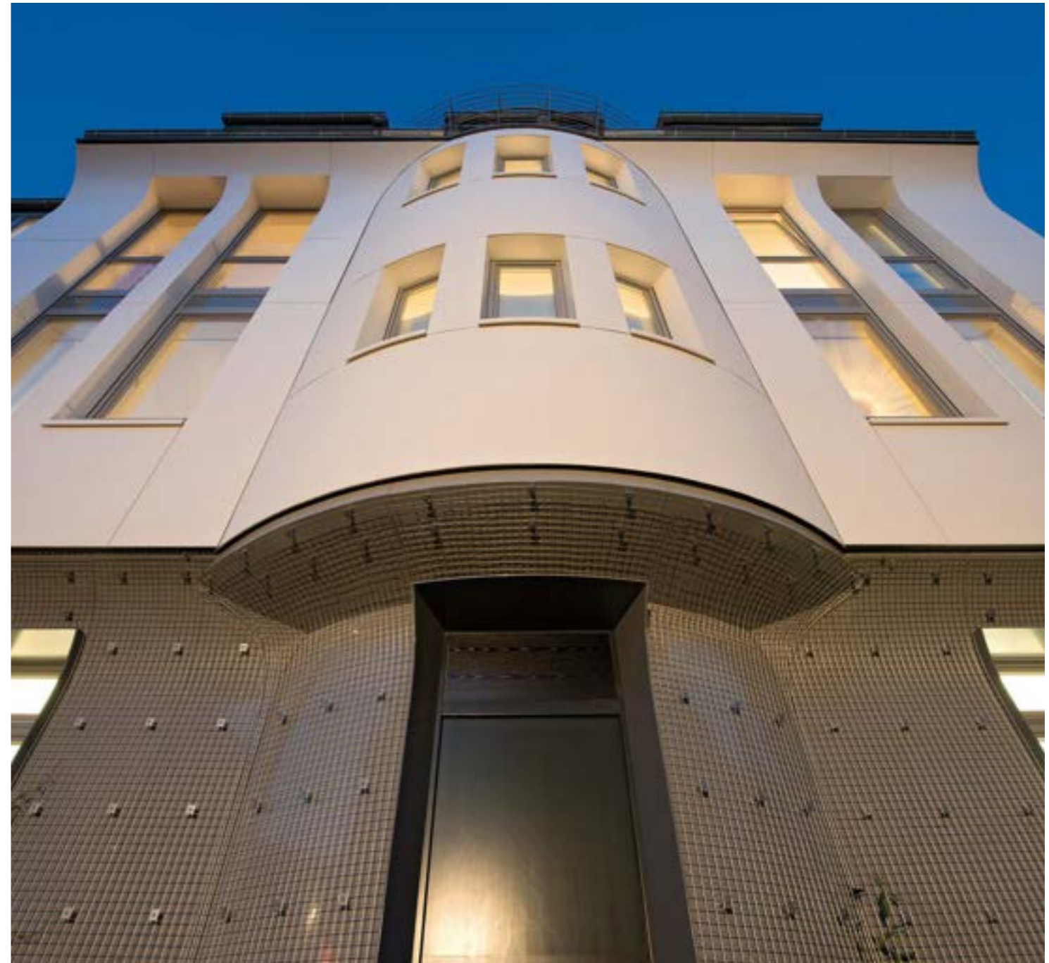
Design: Kohler Architekten | Fabrication: Peter Knapp Dach und Fassadentechnik GmbH, Abalit Elementos Moldeados, Peter Grube | Photo: Nikolaus Herrmann
